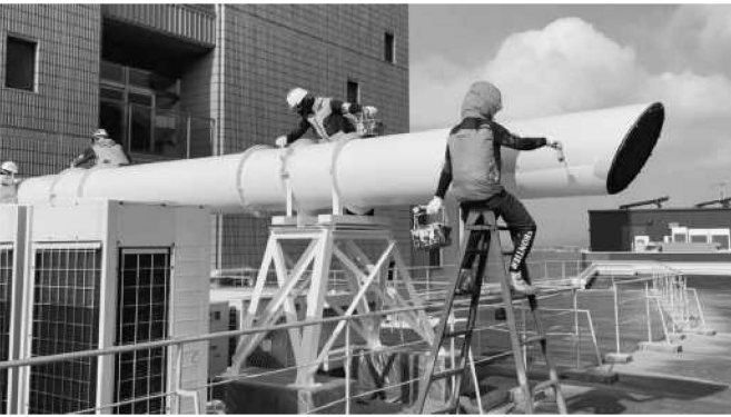
塗膜の強度はコンクリートの20倍程度
